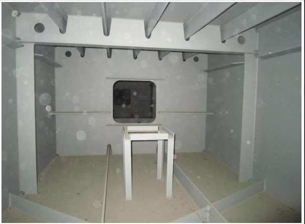
내용 전경 거더내부
