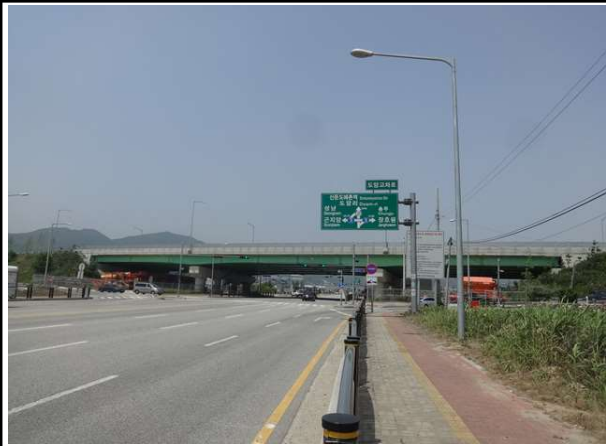
내용 전경 측면
