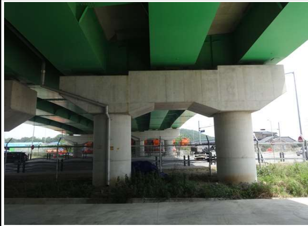
내용 전경 교각
